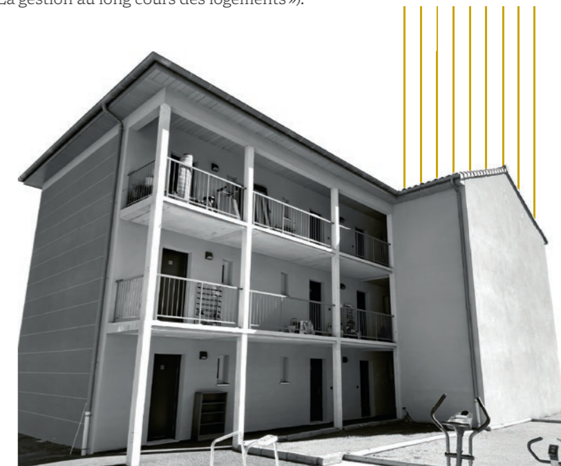
Résidence sociale de la communauté d'Aurillac © Cantal Habitat
