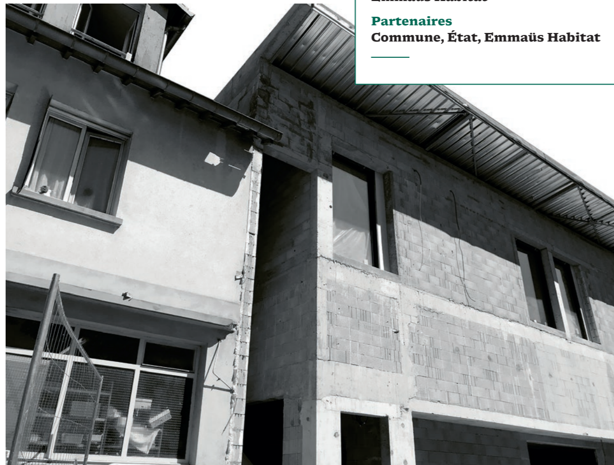
La résidence sociale en travaux (réhabilitation et construction) © Espacité, 2021
